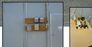
電力積算計、電力記録計を東棟、西棟に取り付け、電力量を記録。
